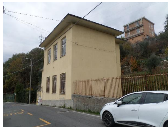
Figura 1.1 - Vista della facciata esposta a sud
