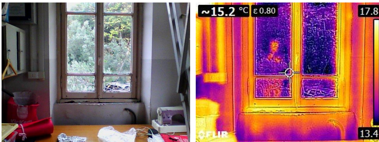
Figura 4.5 –Rilevo termografico dei serramenti
