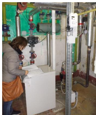
Figura 4.8 –Sonda Temperatura ritorno centrale
