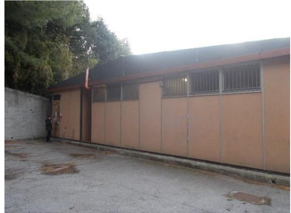
Il profilo termico della struttura è dovuto in gran parte alla sua morfologia: pareti e copertura non isolate.
