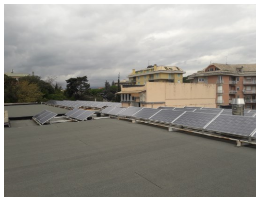
Figura 8.1 - Particolare della copertura
