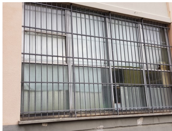
Figura 8.5 - Particolare dei serramenti esistenti
