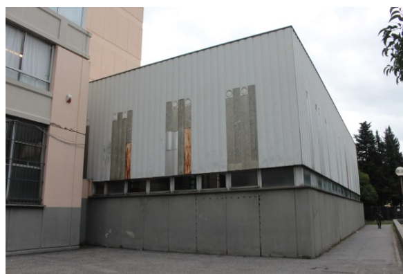
Figura 4.2 - Particolare della facciata della palestra
