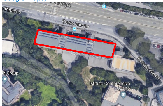
Figura 2.2 - Vista satellitare dell’edificio (Fonte: Google Maps)
