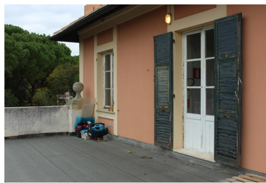
Figura 8.1 - Particolare copertura piana esistente
