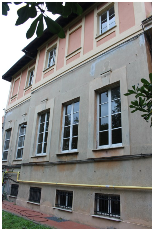
Figura 4.1 - Particolare della porzione di involucro , prospetto Sud Ovest
