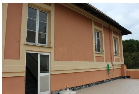
Figura 4.2 - Particolare della facciata NE Piano Primo
