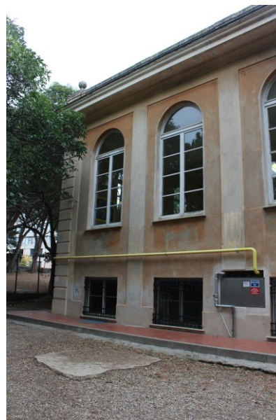
Figura 1.1 - Vista della facciata esposta a Est
