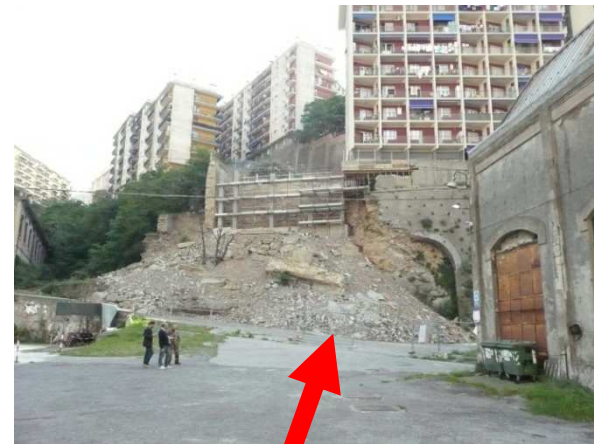
messa in sicurezza idro - geologica
