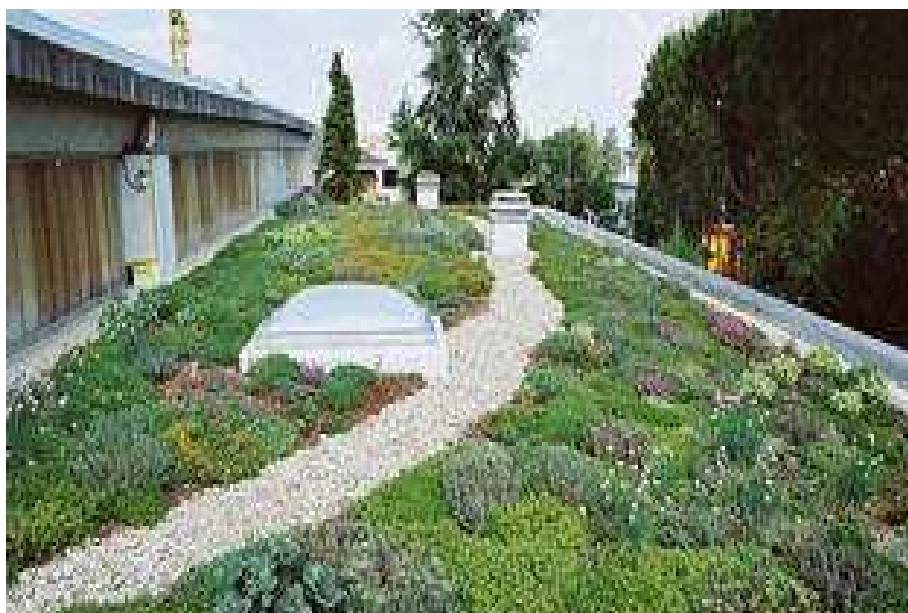
Tetto verde estensivo
