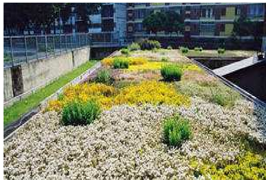
Tetto verde estensivo
