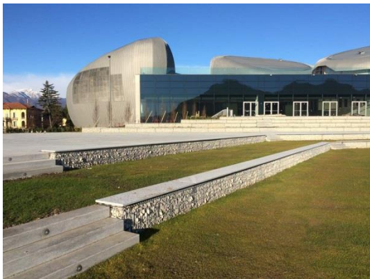
Gabbionate da resti demolizioni
