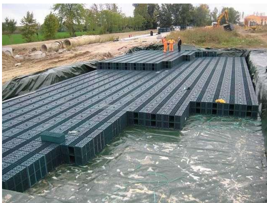
Camere di ritenzione delle piogge
