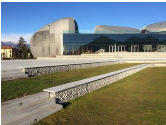
Gabbionate da resti demolizioni
