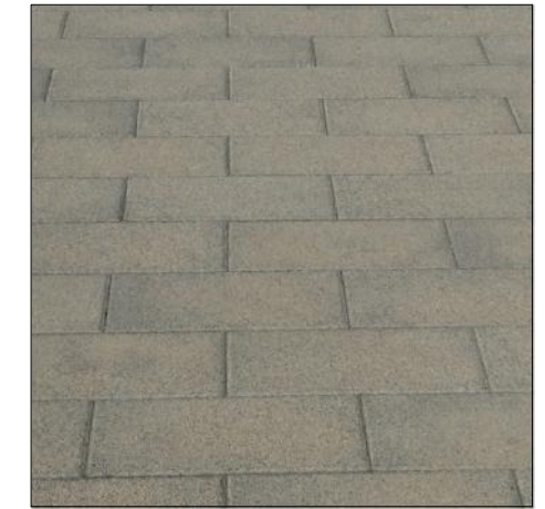
PAVIMENTAZIONE FASCIA DI RISPETTO PRA'
