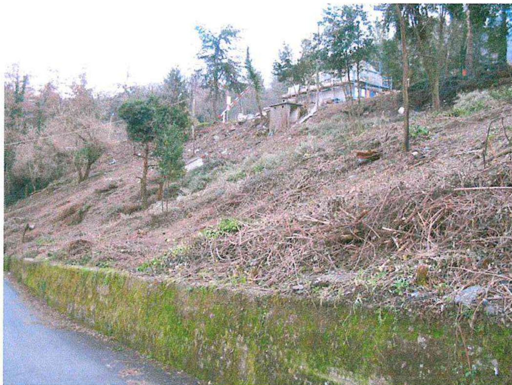
Foto n. 1 – Vista dal basso dell'area d'intervento.
