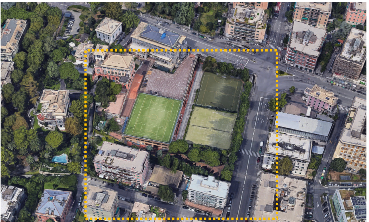
Vista aerea dell'area di intervento
