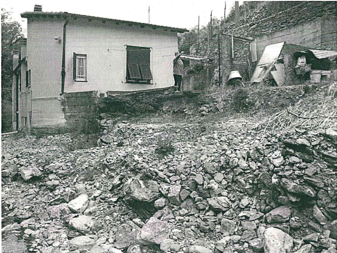
Foto 8: Stato dei luoghi
