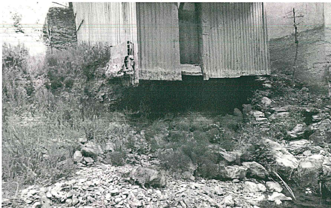
Foto 5: Stato dei luoghi
