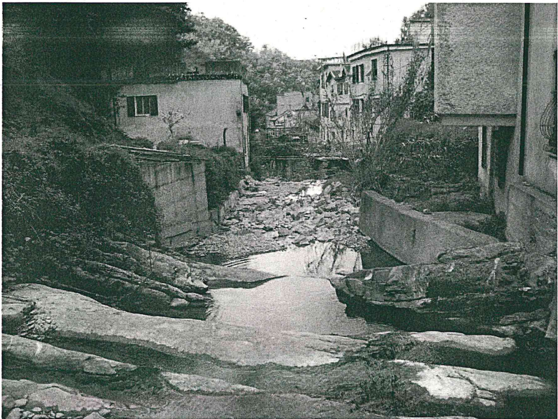
Foto 7: Stato dei luoghi
