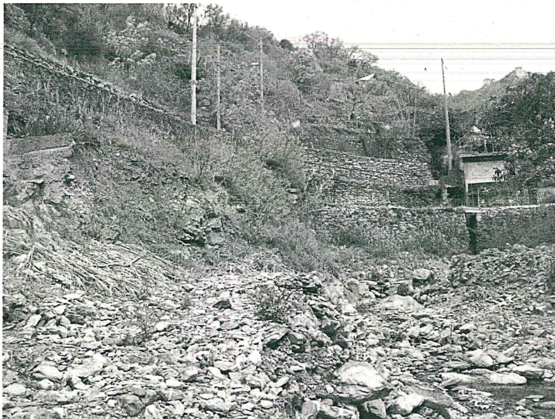
Foto 9: Stato dei luoghi
