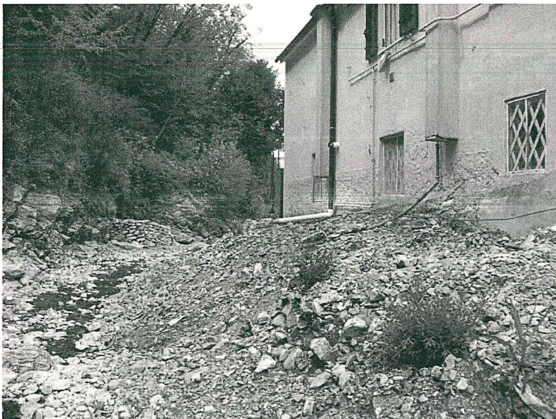
Foto 10: Stato dei luoghi
