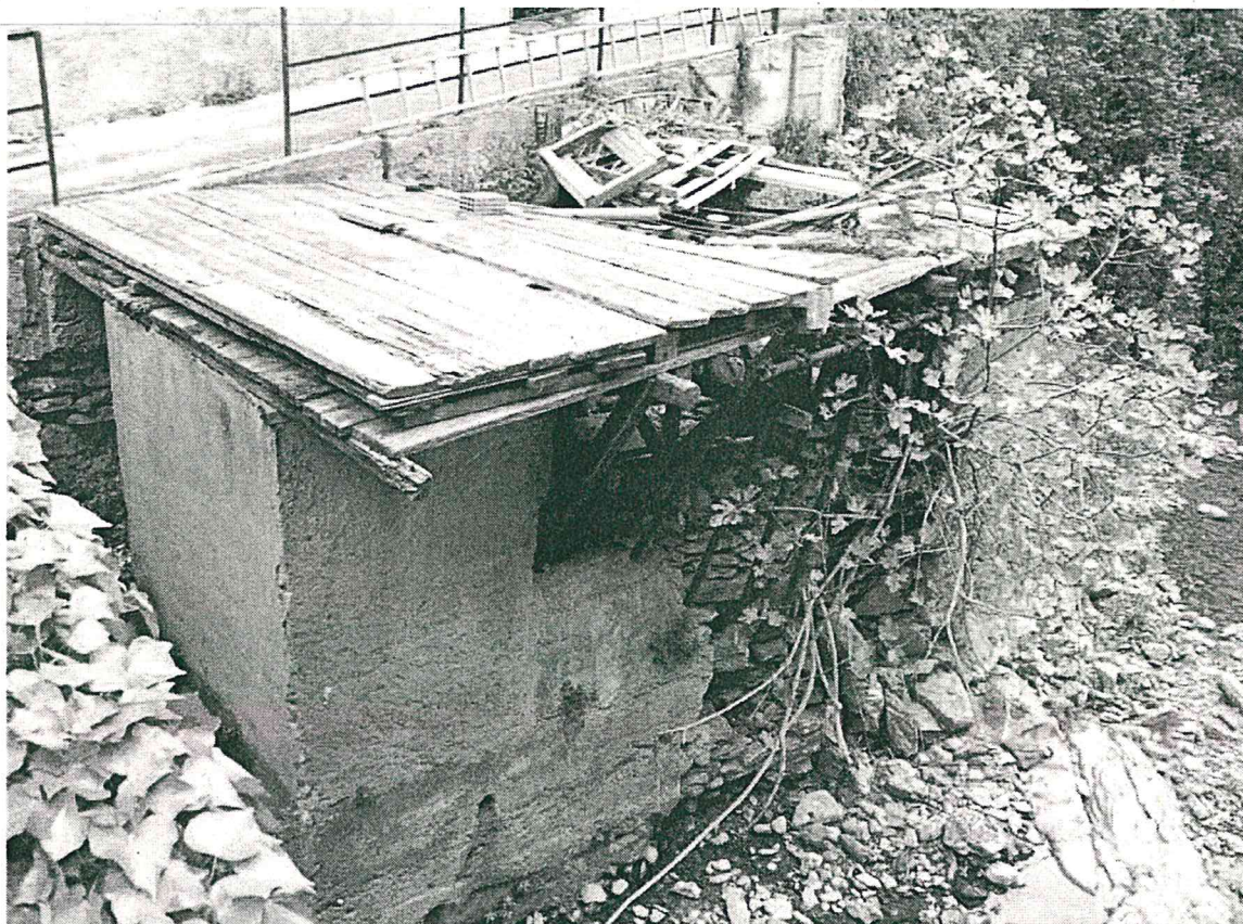
Foto 6: Stato dei luoghi
