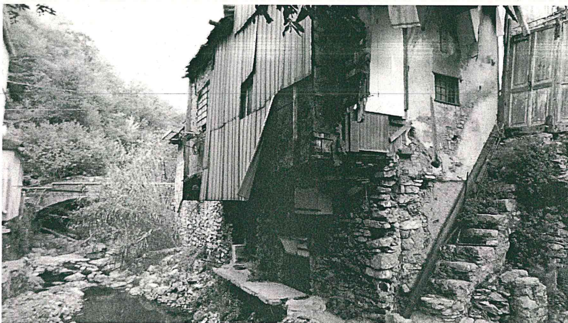
Foto 2: Stato dei luoghi
