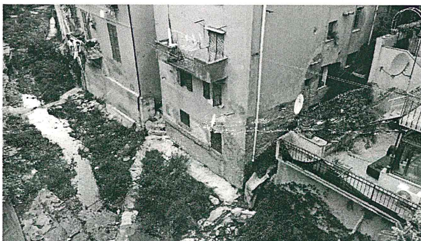
Foto 4 – Stato dei luoghi
