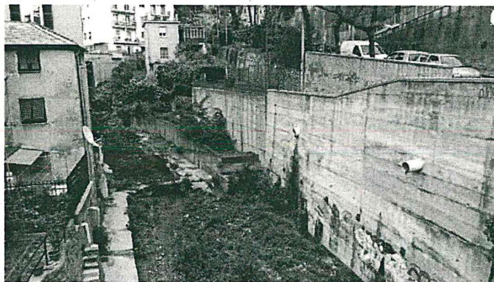
Foto 3 – Stato dei luoghi
