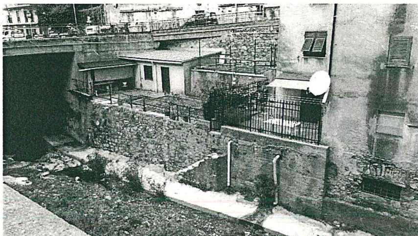
Foto 1 – Stato dei luoghi
