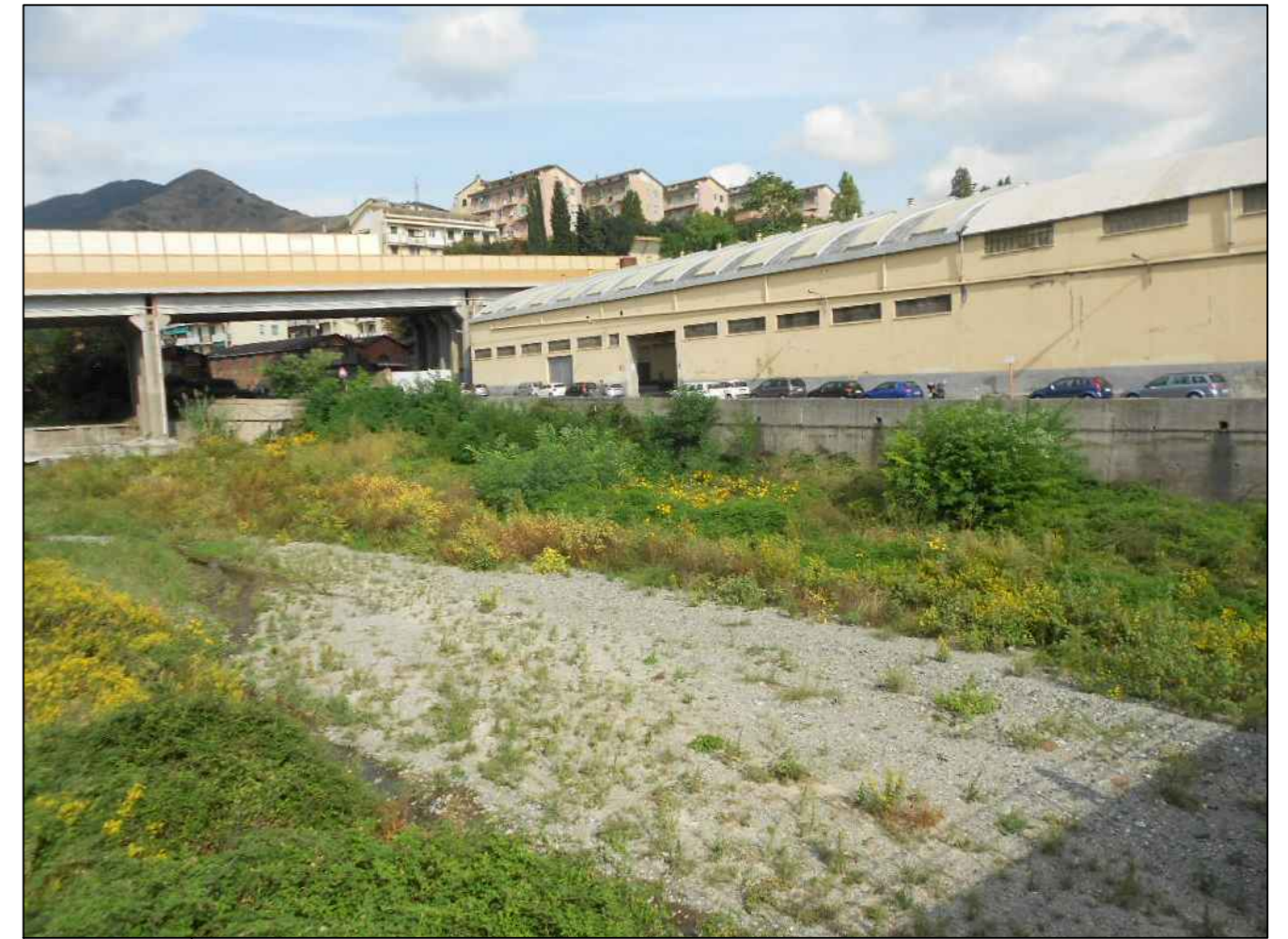
Alveo prima dell'intervento
