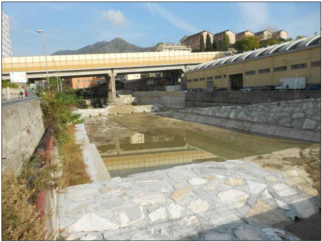
Vasca di Monte a lavori ultimati
