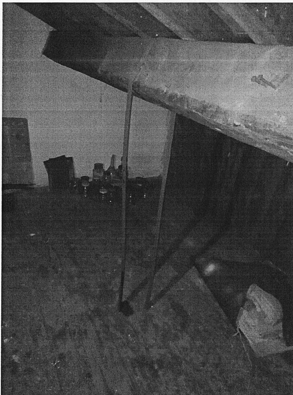
Piano Sottotetto - catena lato ovest
