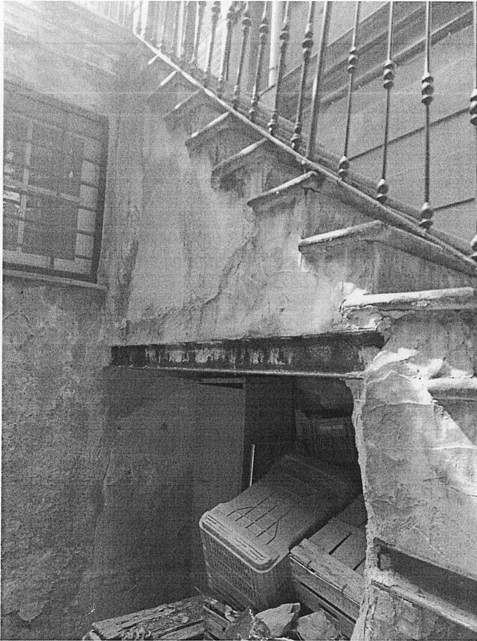
Scala di accesso a piano primo
