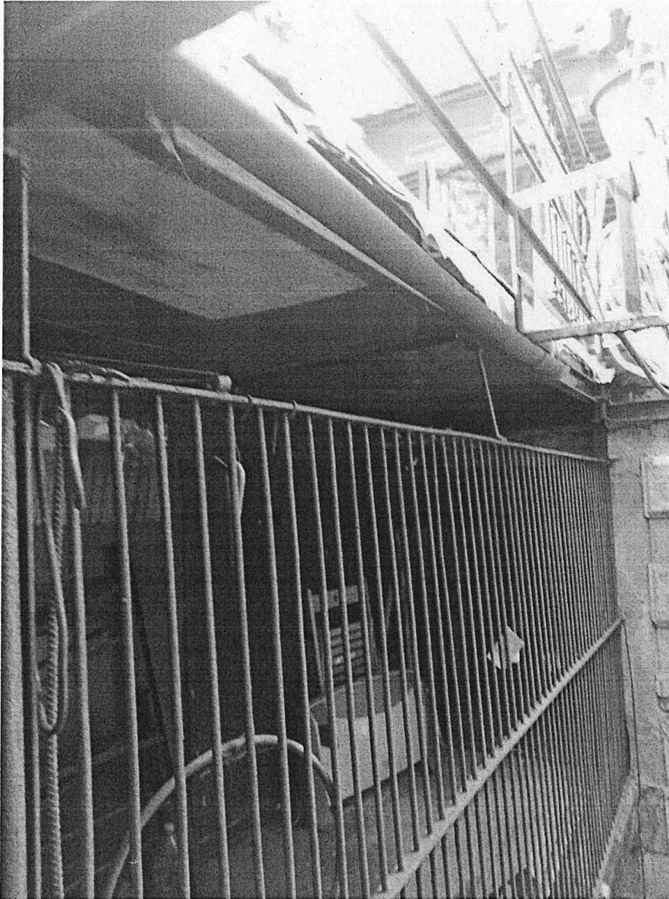
Intradosso solaio di copertura magazzino
