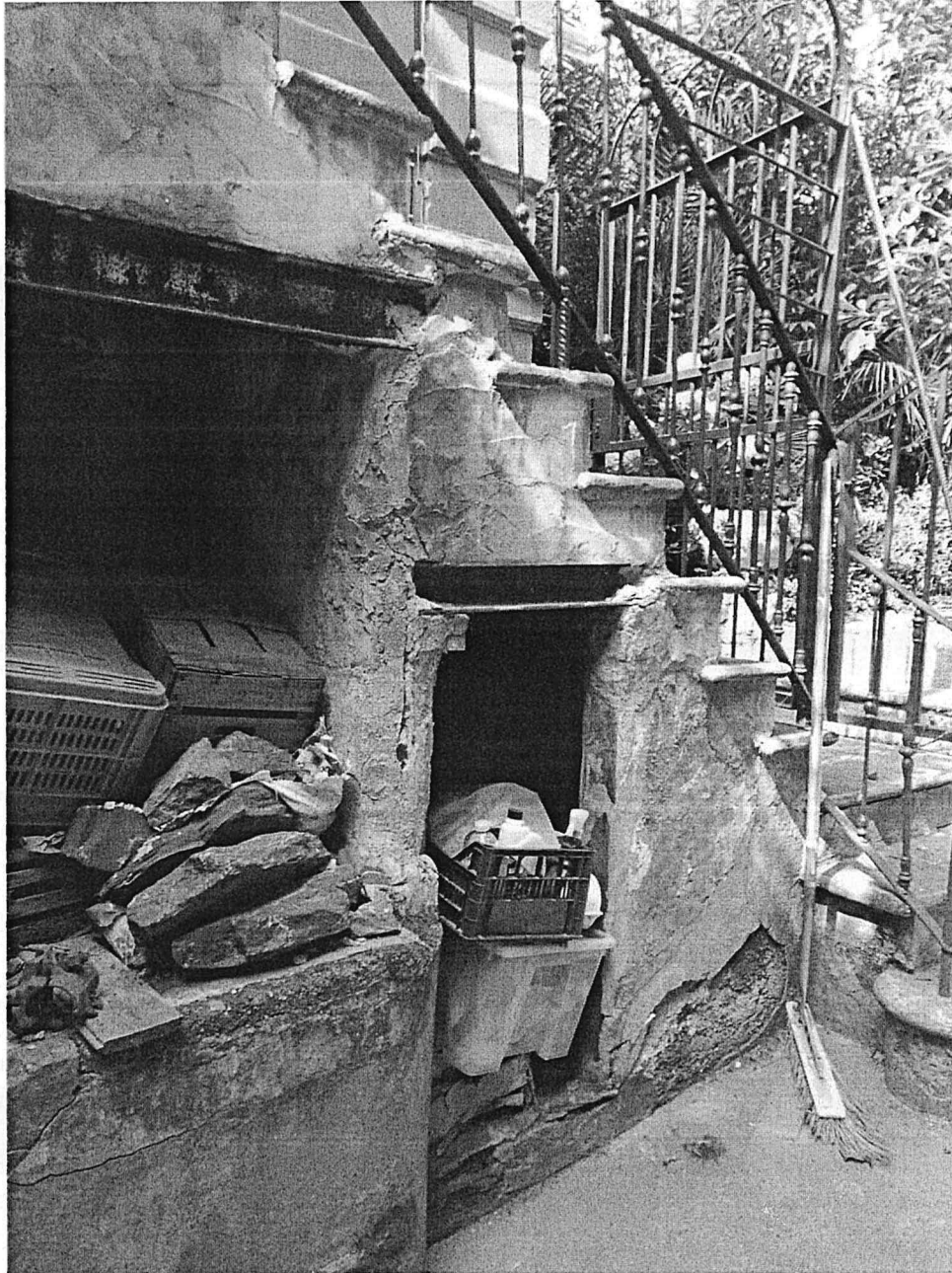
Scala di accesso a piano primo
